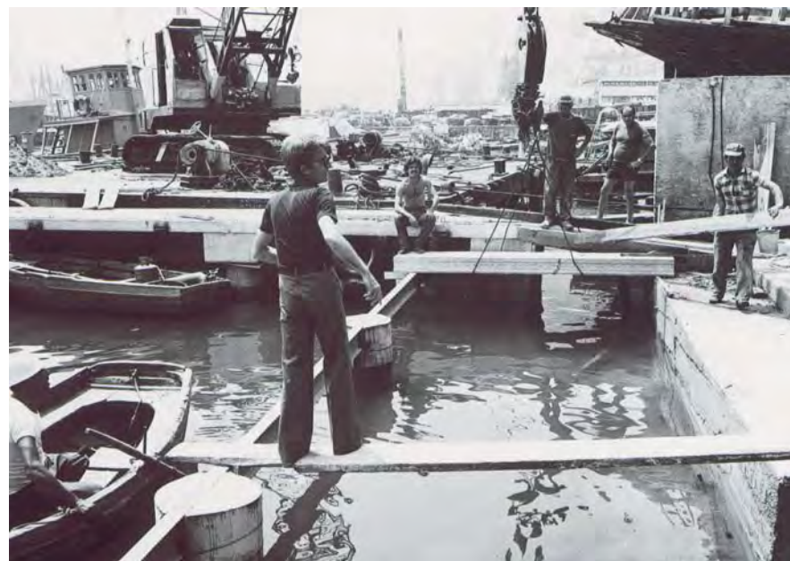
Angelo Troisi e Tonino Buonomo a pesca sul pontile Il vecchio pontile in fase di disarmo Giovanni Parrilli dirige i lavori per il nuovo pontile
