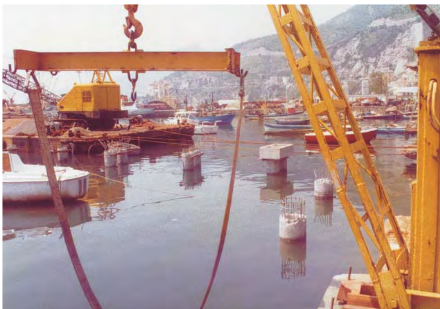
Sistemazione dei pali per la costruzione del nuovo pontile Uno scorcio dei lavori con il pontone battipalo
